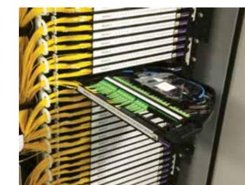
Rack 19" coupleur pivotant 1U pour armoire de rue, incluant coupleur PLC (1x16 ou 1x32 fibres G.657.A2), connecteur en SC/APC (16 ou 32 raccords) et cassette épissure pour l'entrée du coupleur.
