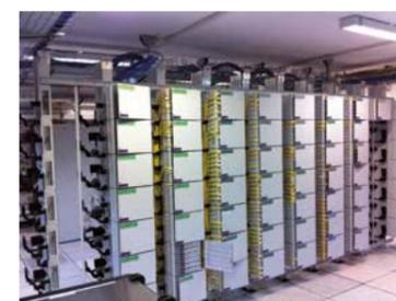
Destinée au brassage de grandes quantités de fibres au NRO. Chaque poutre peut accueillir jusqu'à 7 têtes optiques composées de 144 fibres, soit une capacité de plus 1 000 fibres.
