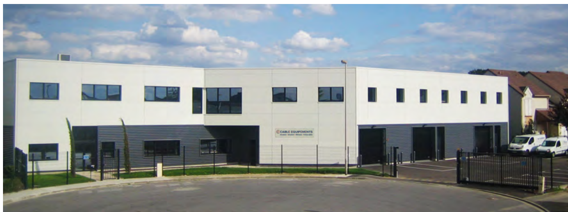
Le bâtiment principal de notre usine, située à Noiseau (94), France
