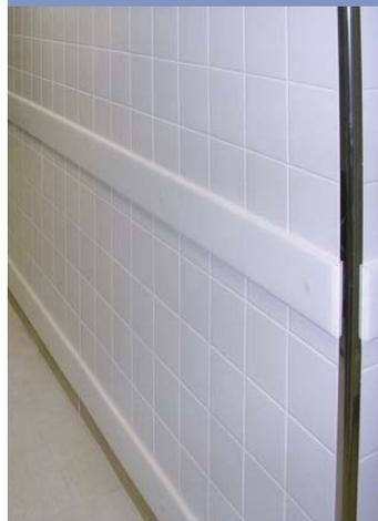
Pour une protection optimale de vos murs contre les agressions de chariots ou transpalettes, les lisses de protections en PEHD peuvent être installées à toutes hauteurs. Robustes, les lisses sont, par défaut :
