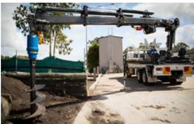
POUR GRUE DE CAMION
