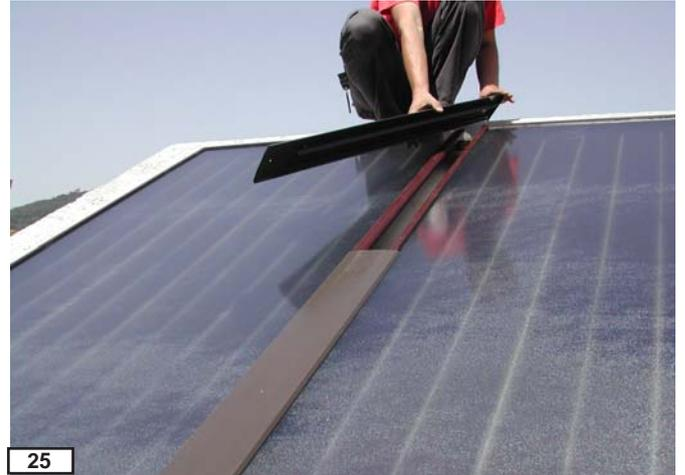
Monter ensuite la couverture intermédiaire supérieure: faire correspondre l'extrémité de celle-ci avec le bord supérieur du panneau, puis la fixer par simple pression (encastrement).
