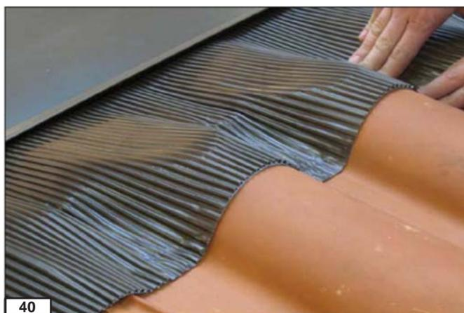
Après avoir nettoyé correctement les tuiles, plier la bavette souple d'étanchéité de manière à ce qu'elle épouse parfaitement les courbes des tuiles, puis la fixer par collage.
