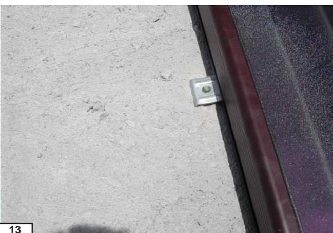
Fixer solidement le panneau solaire sur la charpente de la toiture.
