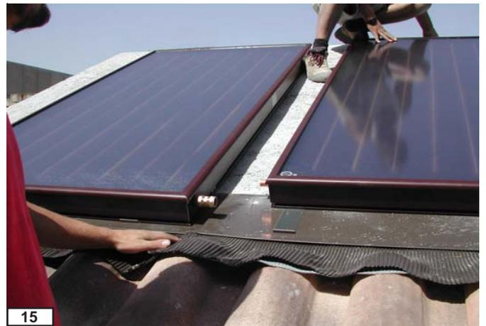
Faire attention de bien faire correspondre la partie inférieure du panneau solaire avec les petites équerres de maintien intégrées d'origine sur le module de couverture inférieur.
