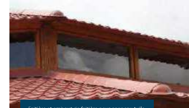
Faitière et embout de faitière pour panneau tuile.
