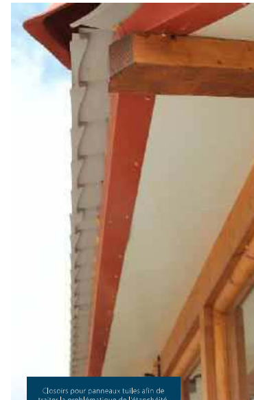
Closoir pour panneaux tuiles afin de traiter la problématique de l'étanchéité.
