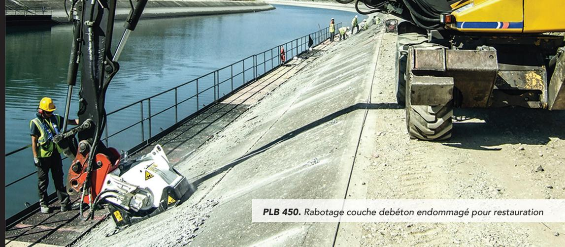
**PLB 450. Rabotage couche de béton endommagé pour restauration**
