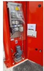
Le poteau de réception type caisson emprisonnant l'extrémité avant du vantail et rigidifiant l'ensemble de l'installation en position fermée, dispose d'un reposoir et d'un guidage latéral réglables. Une butée arrière avec reposoir est fournie avec chaque portail. Les cellules de sécurité sont à l'abri du vandalisme et des intempéries derrière des pareclozes démontables.
