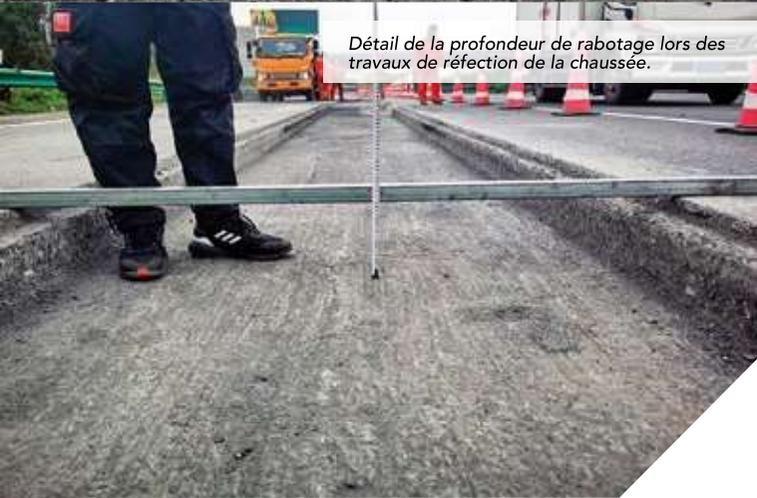
*Détail de la profondeur de rabotage lors des travaux de réfection de la chaussée.*
