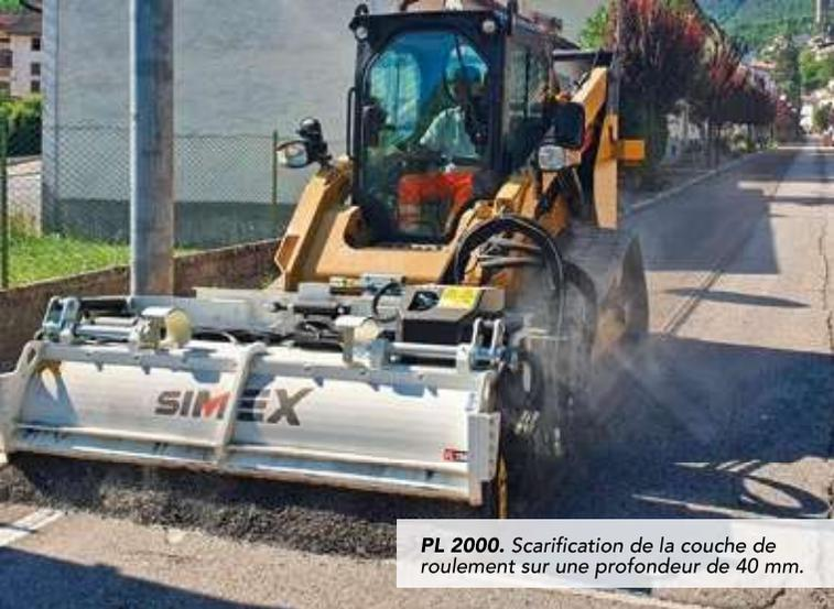
*PL 2000. Scarification de la couche de roulement sur une profondeur de 40 mm.*
