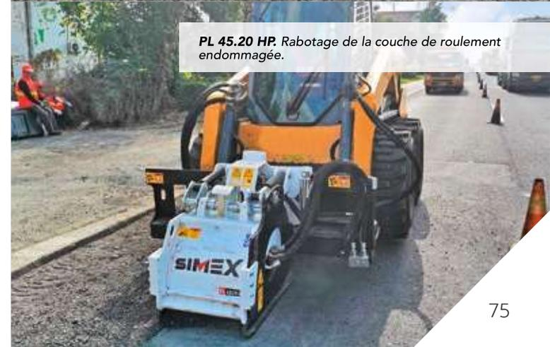
PL 45.20 HP. Rabotage de la couche de roulement endommagée.
