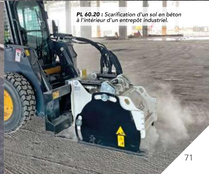
**PL 60.20** : Scarification d'un sol en béton à l'intérieur d'un entrepôt industriel.
