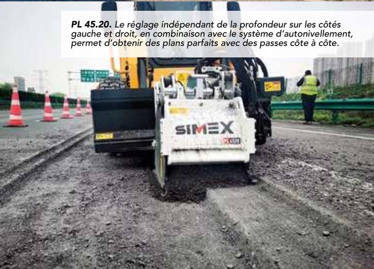
*PL 45.20. Le réglage indépendant de la profondeur sur les côtés gauche et droit, en combinaison avec le système d'autonivellement, permet d'obtenir des plans parfaits avec des passes côte à côte.*
