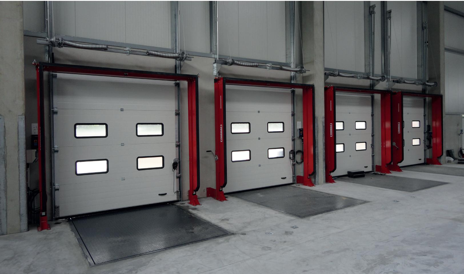
Cette barrière de rétention manuelle certifiée TUV et VdS est construite en forme de U, ce qui la rend idéale pour une utilisation sur les quais de déchargement. En position verticale, (non-actif) la barrière se trouve contre le mûr - autour de l'ouverture de quai.
