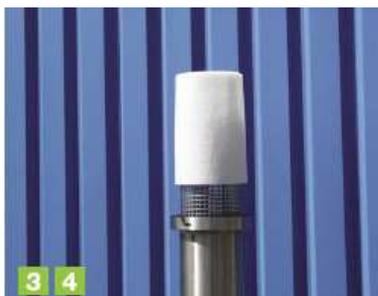
5. Enfin la colonne de prise d'air ainsi préparée pourra être raccordée au puits canadien. Pour ce faire , le bout mâle côté inférieur de la colonne inox est à lubrifier et à introduire jusqu'en butée dans le manchon double en PP du puits canadien.
