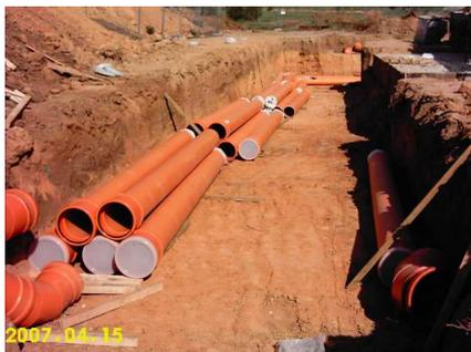
En ce qui concerne le lit de pose la mise en œuvre de sable est à proscrire sauf si ce dernier constitue le terrain naturel. Le lit de pose est réalisé avec le matériau extrait expurgé de tout élément grossier (Diamètre supérieur à 35 mm)
