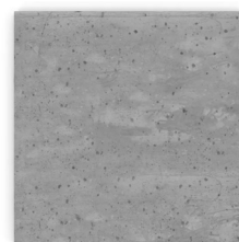
Béton Dosage : 350kg/m 3 Volume : 0,48m 3
