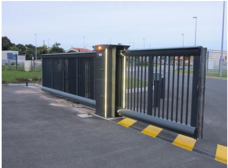
La **signalisation est assurée par 2 feux clignotants 5w à leds de couleur orange à très longue durée de vie sur le capot composite coté intérieur et extérieur et l'éclairage par 2 bandes à leds de 29 W (en 2m).**
