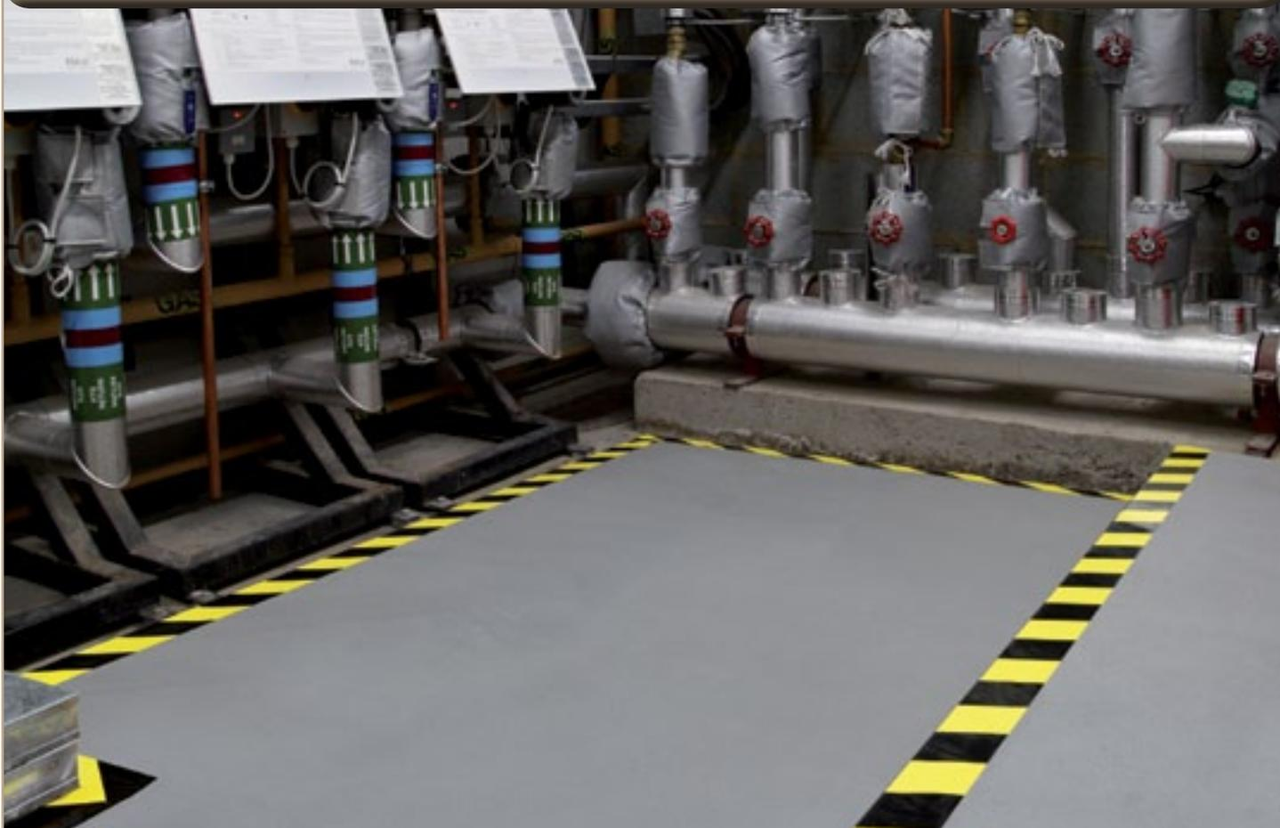
Dans les aires de production, il est important que les déversements accidentels et les fuites soient contenus. Les pertes d'eau et de produits chimiques provoquées par la rupture de canalisation d'un tuyau ou d'un container, peuvent même endommager les pièces du dessous, en cas d'infiltration à travers les joints et les fissures.
