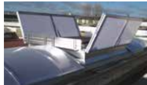
Rehausse dans voûte
