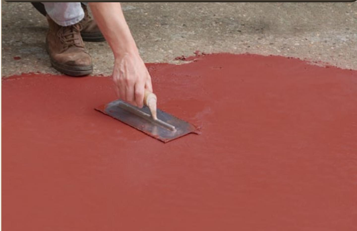
Enduit'color est un enduit à base de résine et de silice. Il transforme les bétons et bitumes endommagés et usés en une surface anti-poussière, fermée et attrayante. Ce produit est prêt à l'emploi et sa consistance crémeuse s'applique facilement au plateau.
