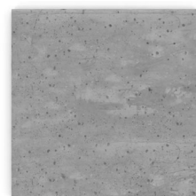
Béton Dosage : 350kg/m 3 Volume : 0,75m 3
