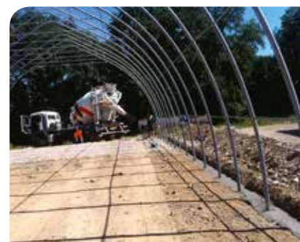
Préparation des tranchées béton et mise en place du fer à béton.
