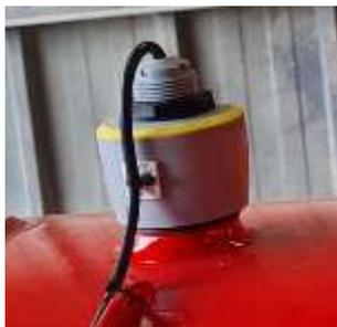
Le niveau est mesuré par un radar monté sur la citerne et est affiché au tableau. Une sécurité coupe la pompe à vide au niveau haut.
