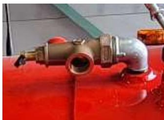
**Deux soupapes** de sécurité, tarées et plombées, assurent la sécurité des opérateurs. **Une sur le circuit et une sur la citerne, en amont et en aval de la vanne d'isolement.**
