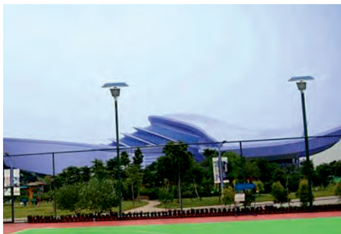
Eclairage stade extérieur
