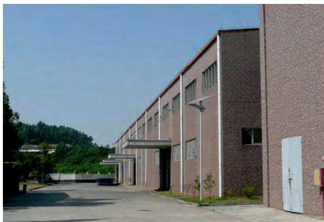
Eclairage Zone Industrielle
