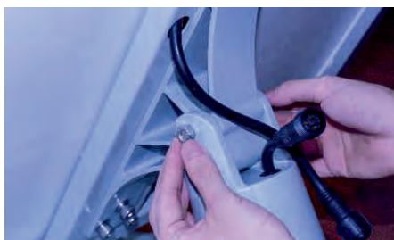
1. Montez le module de support vertical (étape 3) sur le support horizontal, maintenez le module de support vertical à l'arrière (avec 3 vis ) orienté vers l'avant de la lanterne, serrez d'abord la vis inférieure et les autres après avoir ajuster le panneau solaire verticalement.
