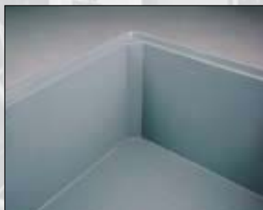
Fond et parois latérales fermés.
