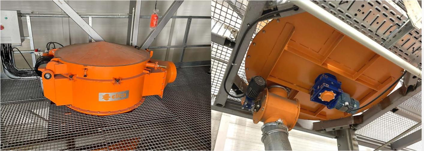
Le filtre à air basse pression ELICA assure une filtration efficace des particules de poussière contenues dans l'air.
