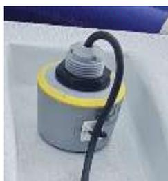
Le niveau est mesuré par un radar monté sur la citerne et est affiché au tableau. Une sécurité coupe la pompe à vide au niveau haut.
