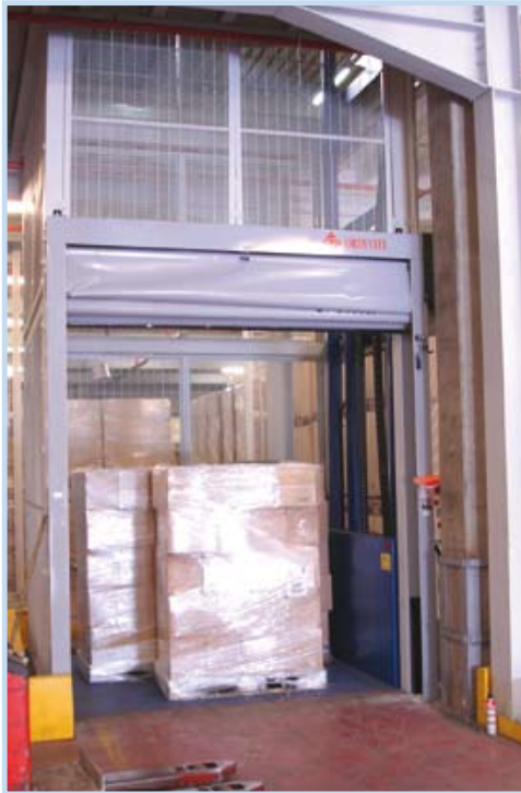
Porte rapide en partie basse avec commande par boîte à boutons et portillon en partie haute
