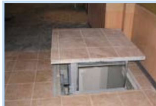
Trappe embarquée sur le point haut de la cage de l'élévateur
