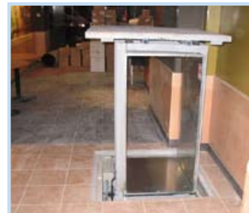
Trappe embarquée sur le point haut de la cage de l'élévateur
