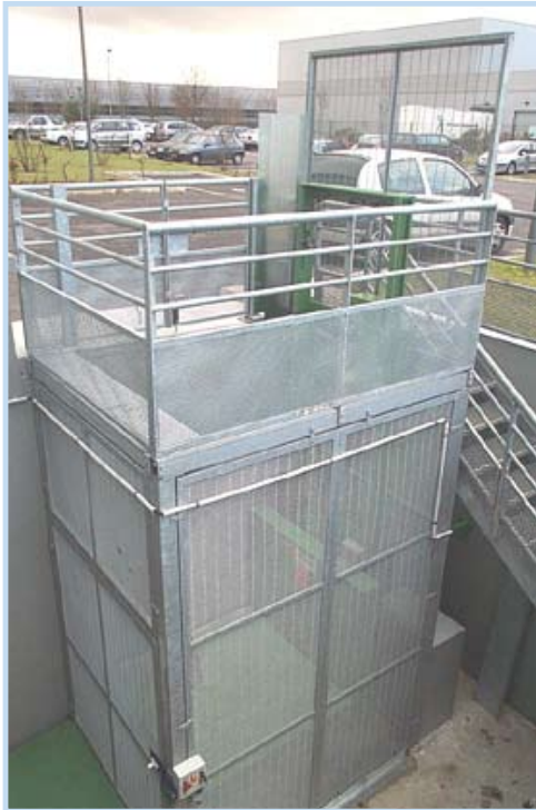
Gaine de l'élévateur réalisée suivant l'existant
