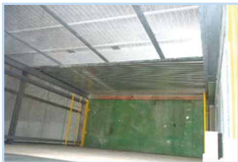
Elévateur charge 4000 kg, plateau 4500 x 1800 mm, course 6000 mm
