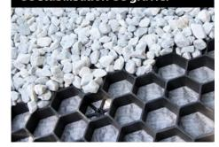
Il s'agit de la partie la plus facile, le gravier ou gravillon peut simplement être éparpillé ou déversé sur les plaques. L'épaisseur de la couche nécessaire est de 5-6 cm. Ainsi, pour 20 m<sup>2</sup> 1 m<sup>3</sup> de gravier ou de gravillon est nécessaire. Ratissez bien le gravier partout de manière à ce que toutes les plaques soient entièrement
