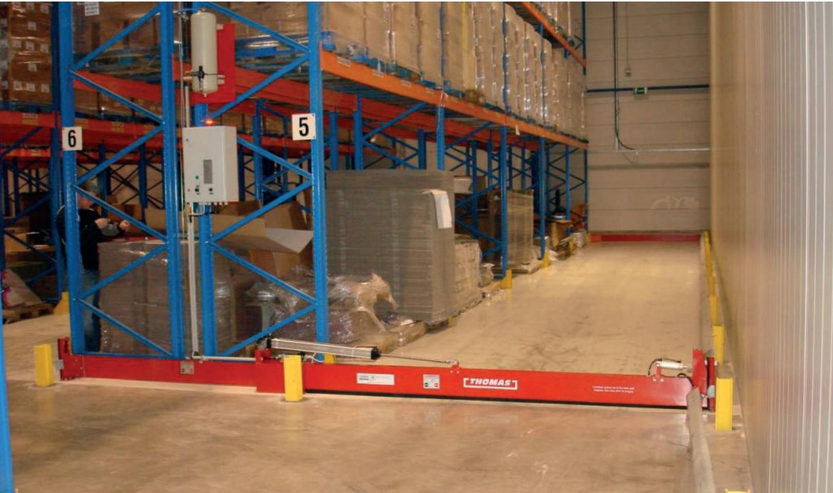
En position de repos, cette barrière de rétention entièrement automatique est située verticalement à côté de l'ouverture et elle est tenue dans sa position verticale par un cylindrique pneumatique.
