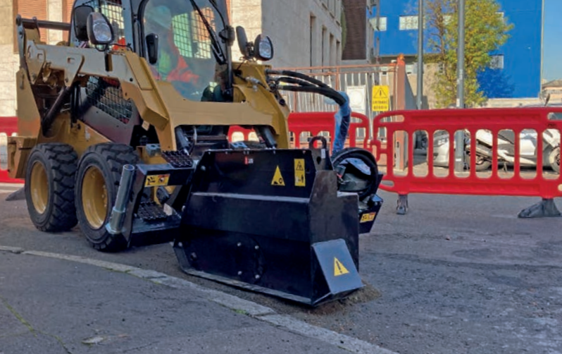
T 300 Micro tranchée micro-tranchée avec un disque de 25 mm de large.
