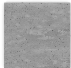
Béton Dosage : 350kg/m 3 Volume : 0,15m 3
