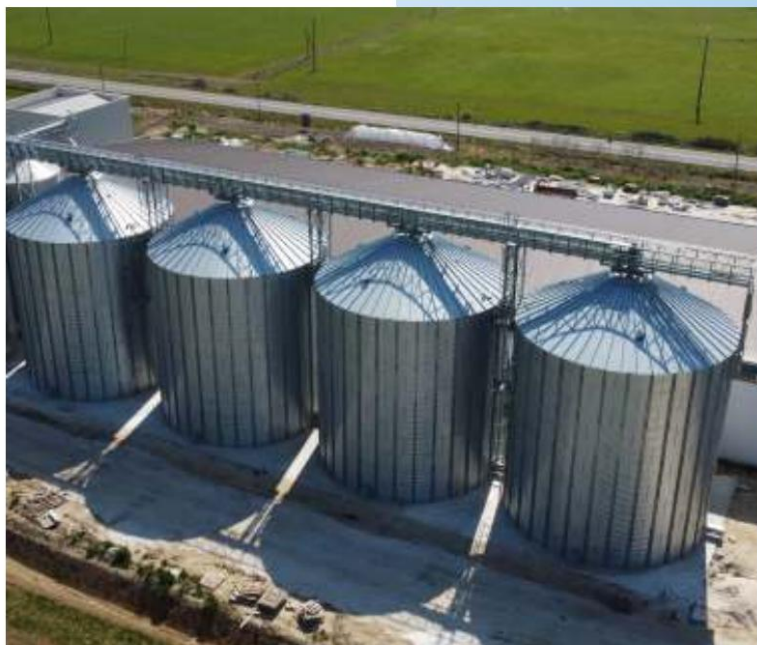
Silos boulonnés à fond plat en tôle ondulée.
