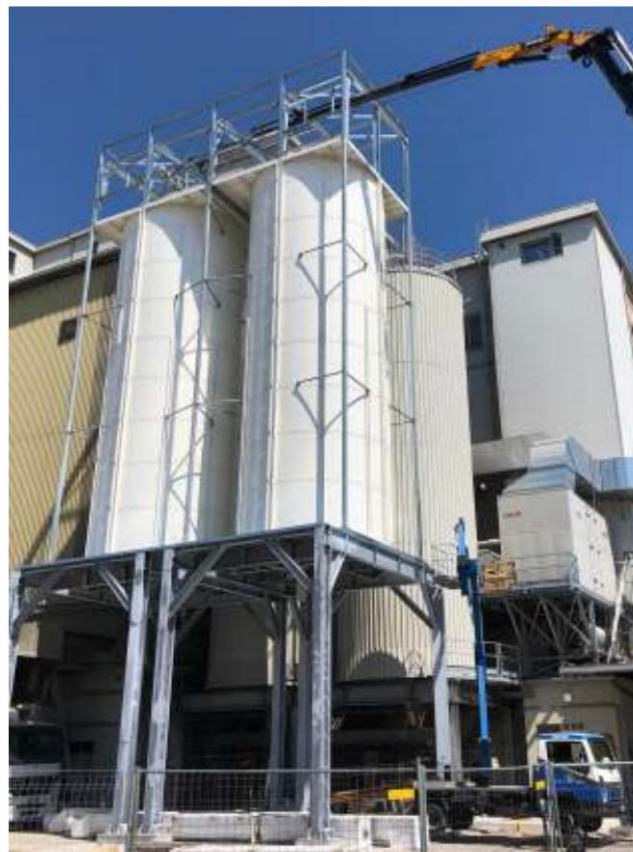
Silos boulonnés lisses thermolaqués à fond plat avec extracteur pour produits non coulants, sur structure métallique pour chargement en camions vrac.
