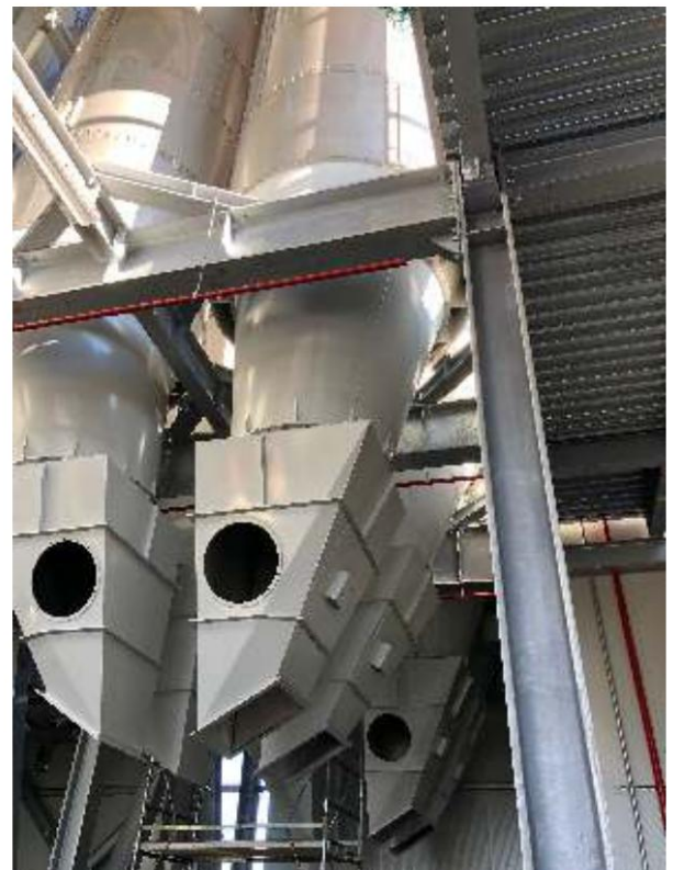
Silos boulonnés lisses avec trémie asymétrique pour chargement de camions en vrac.
