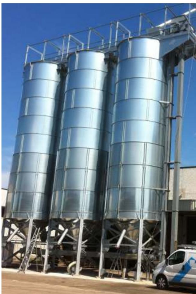
Silos boulonnés lisses sur piliers simples.
