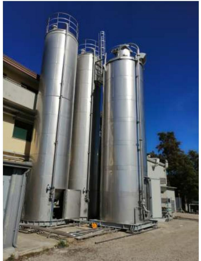
Silos boulonnés en acier inoxydable, sur solution jupe, isolés individuellement, pour déchargement de citernes.
