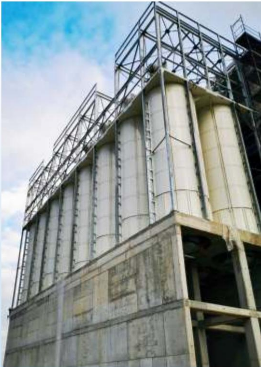
Silos boulonnés lisses thermolaqués, disposés en batterie, sur une structure en béton armé.
