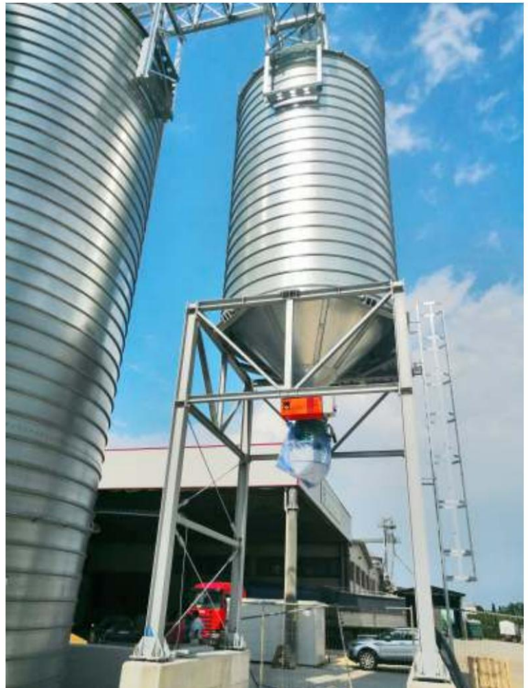
Silo à spirale lisse à trémie, sur structure métallique pour chargement de camions en vrac.
