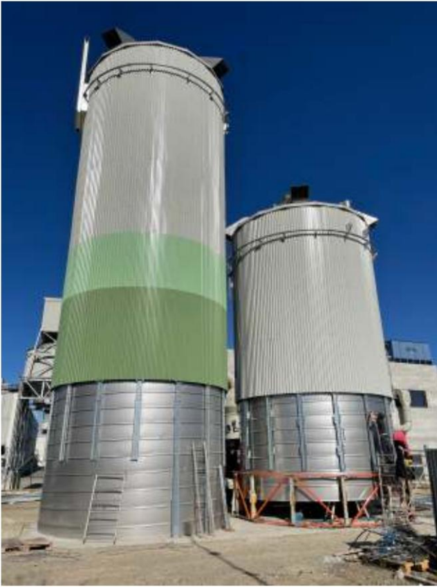
Silos spiralés lisses en acier inoxydable à fond plat et isolés individuellement.
