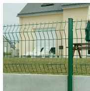
Pose avec plaque de soubassement
