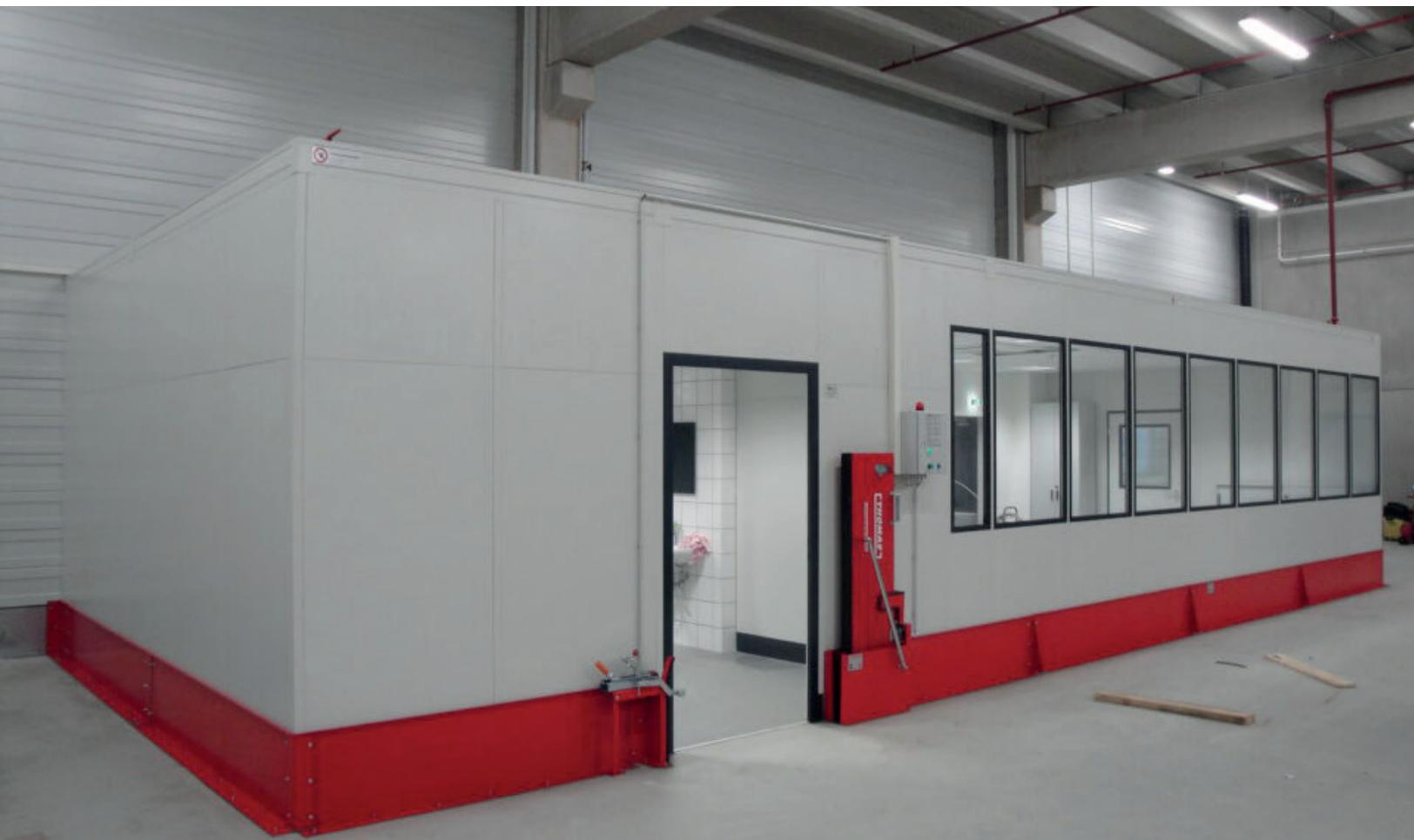
Cette barrière de rétention permanente certifiée TUV et VdS se compose d'un profilé en L, vissé au sol et les murs. Le profilé est placé, fixé et siliconé de manière à être étanche. Les barrières sont placées autour d'une zone pour créer des compartiments ou le long des murs du bâtiment.
