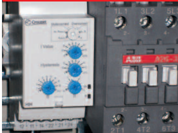
Limiteur électronique de charge Arrête le treuil en cas de surcharge sans rupture de la chaîne cinématique.
