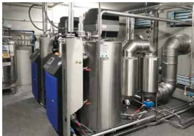
Fig. : Installation de vapeur multiple. Deuxième économiseur JUMAG en aval, installé sur un châssis de base peu encombrant
