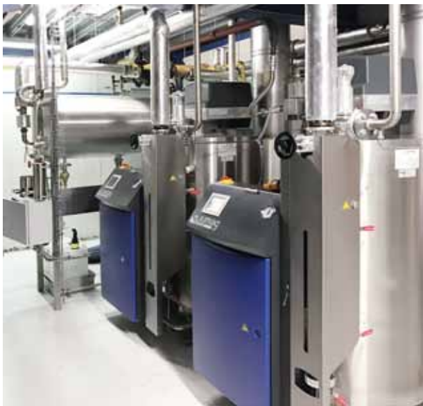
Fig. : Installation de vapeur multiple, conception modulaire
