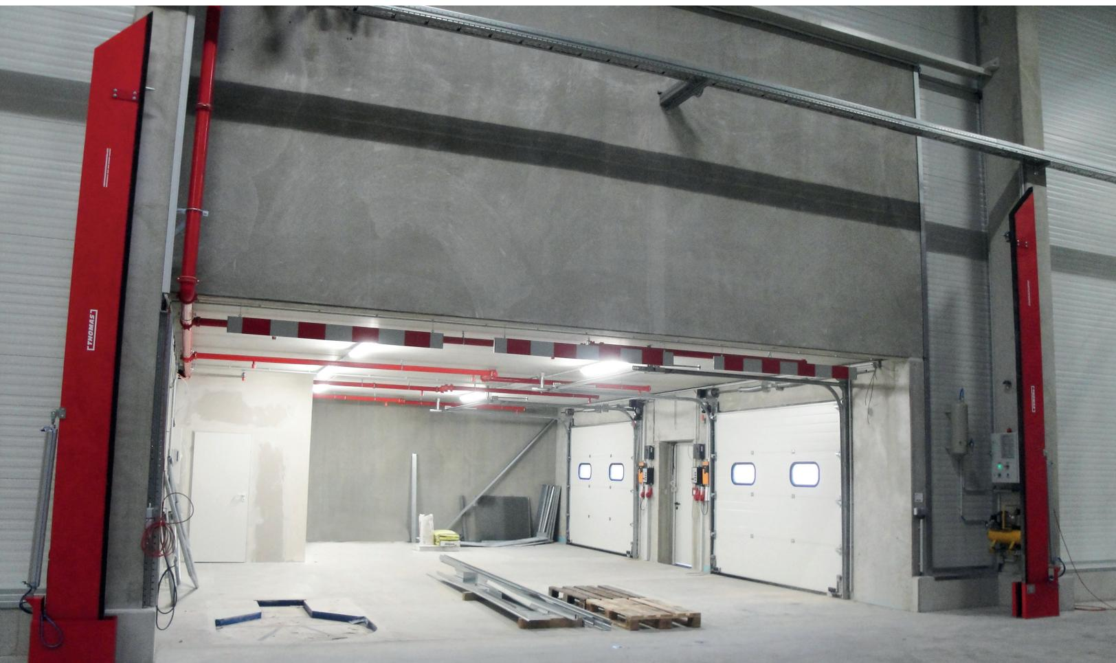
En position de repos, les deux barrières pivotantes entièrement automatiques sont placées verticalement à chaque côté de l'ouverture et elles sont tenues dans sa position verticale par des cylindriques pneumatiques.
