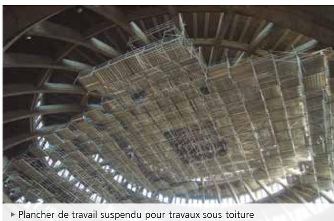
▶ Plancher de travail suspendu pour travaux sous toiture
